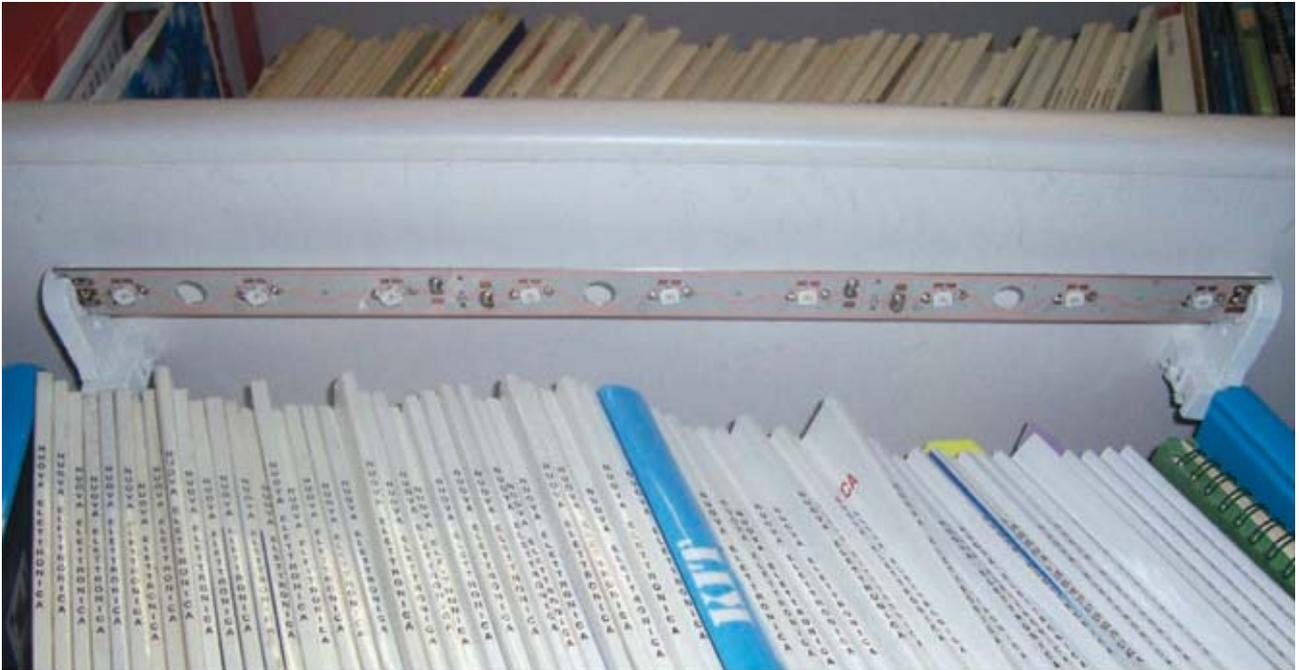
**fig.19** para la fijación de la barra luminosa podéis utilizar los mismo terminales de plástico que se han utilizado para los tubos de neón, y que podéis encontrar con facilidad en cualquier tienda de material eléctrico. Si queréis, podéis insertad la barra luminosa en un tubo de plexiglás, y en este caso realizad una serie de orificios para garantizar una buena circulación de aire.
