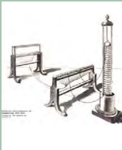
Figura 16.- Telégrafo de Soemmerring.- Tomada de "Del semáforo al satélite", publicación de la U.I.T. de 1965.
